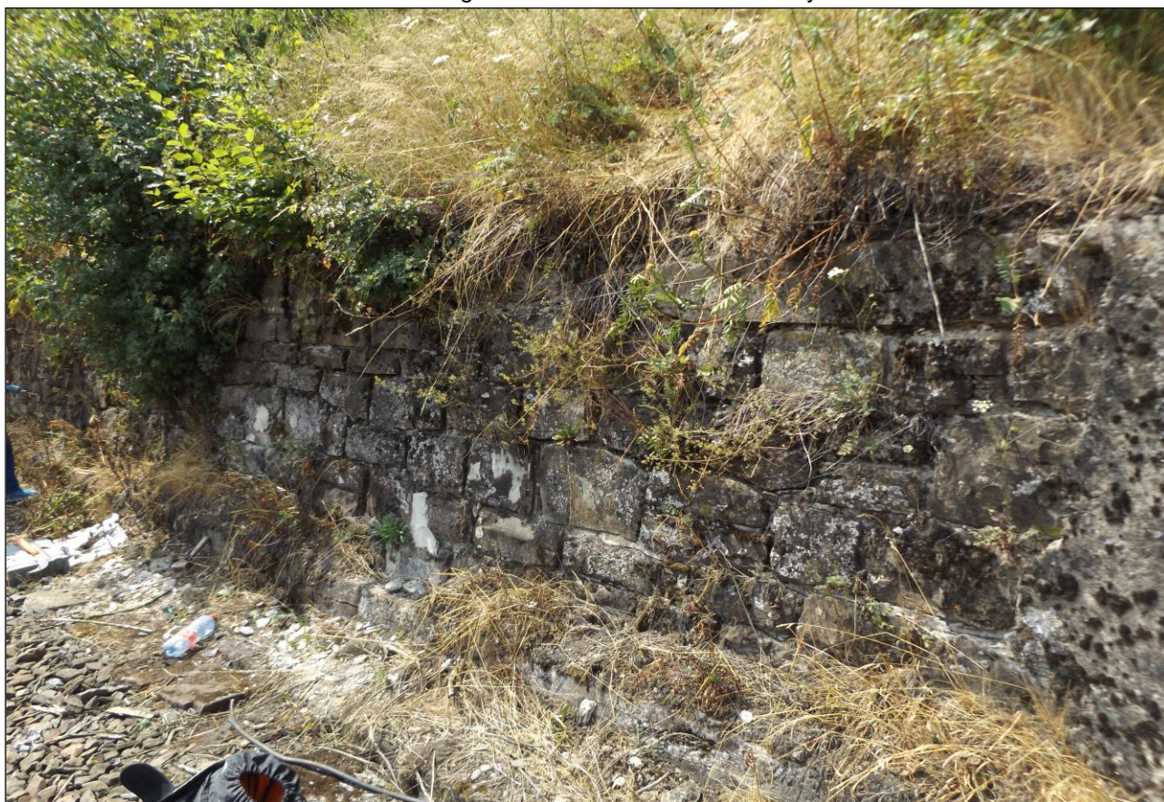
Obr. č. 6 – pohled na zárubní zeď tvořenou řádkovým, kamenným zdivem
