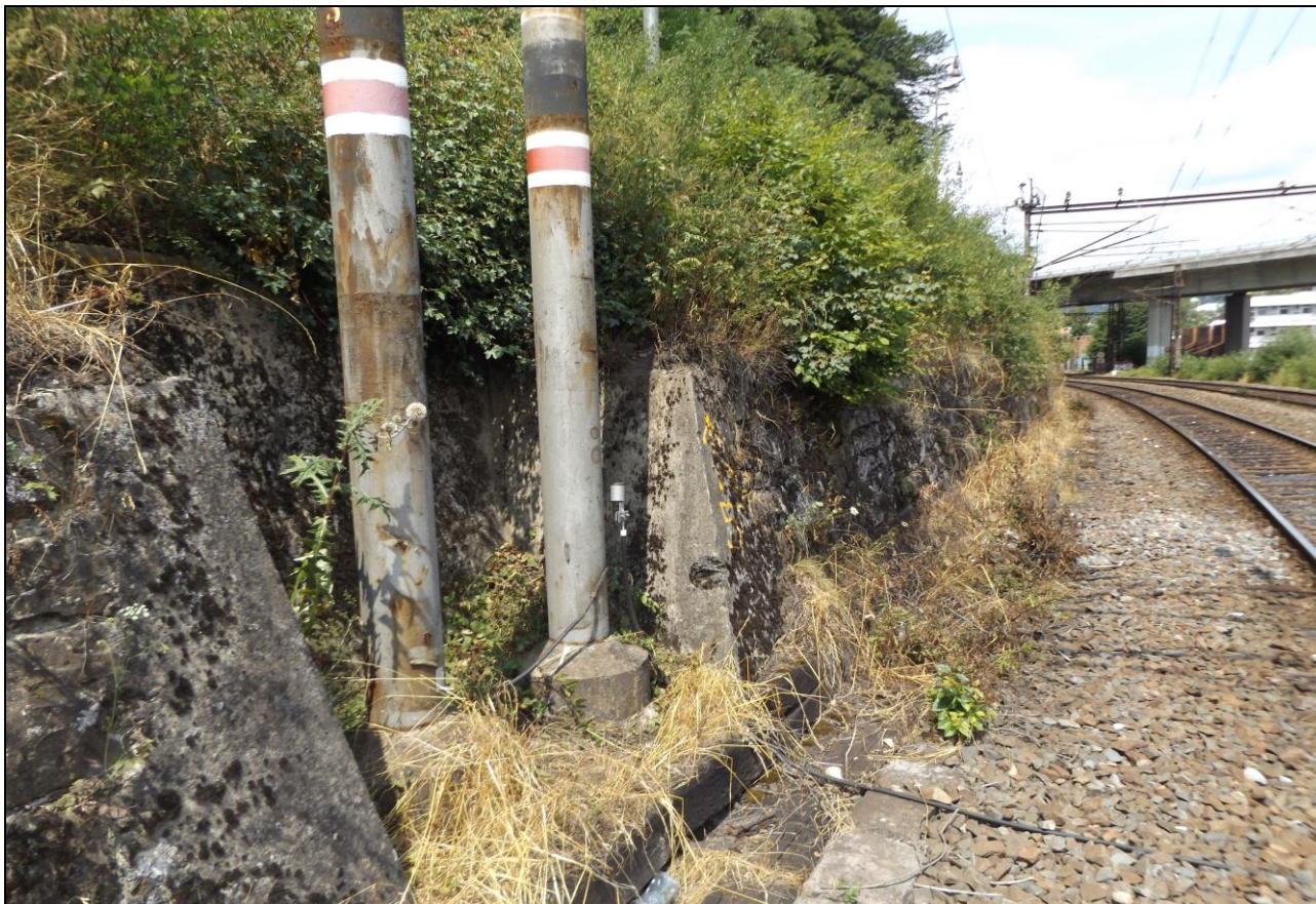
Obr. č. 5 – degradace zárubní zdi od klimatických vlivů
