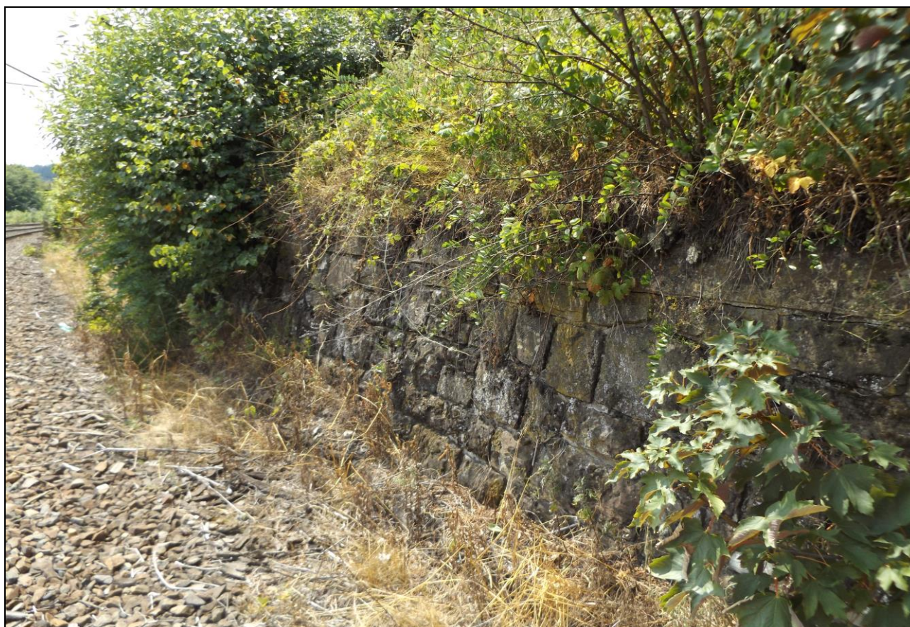
Obr. č. 7 - pohled na zárubní zeď tvořenou řádkovým, kamenným zdivem
